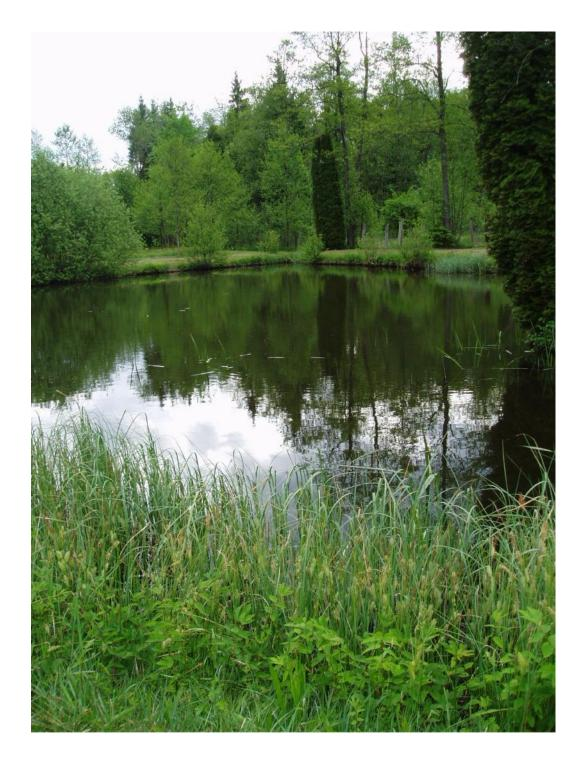
Hier das Beispiel eines naturnah geschaffenen Wasser-Rückhalteraumes durch Vertiefung und Aufweitung des Profils eines Grabenspeichers zu einem Grabenteich als Maßnahme für eine Katastrophenvorsorge. Eine Wasserentnahme für die Bewässerung von Kulturflächen oder als Löschwasser ist stets gewährleistet.
