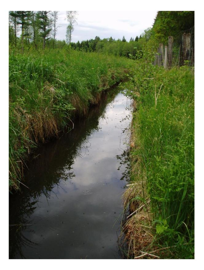
Ein Beispiel für einen Grabenspeicher. Seine Länge von rund 200 m wird durch den natürlichen Uferbewuchs überdeckt. Hier können bis zu 1 000 m³ Wasser gespeichert werden, welche ganzjährig zur Bewässerung von Kulturen oder als Löschwasser bei Bränden zur Verfügung stehen. Und "ganz nebenbei" entsteht ein neues Biotop für die Aquafauna- und flora. Naturschutz kann damit auch gleichzeitig Brand- und Klimaschutz sein.
