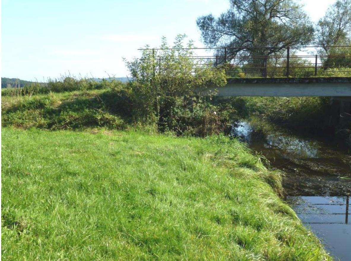
***Das Niveau der Brücke zeigt das Ausmaß einer Moorsackung durch Entwässerung in den vergangenen 100 Jahren. Der Niveauverlust beträgt etwa einen Meter.***
