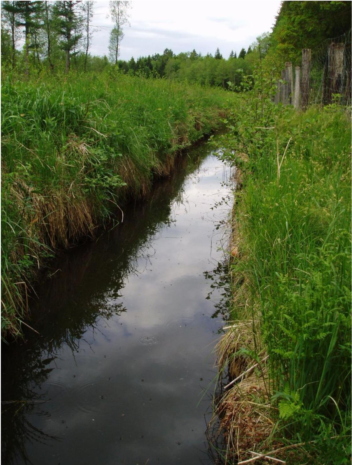
**Ein Beispiel für einen Grabenspeicher. Seine Länge von rund 200 m wird durch den natürlichen Uferbewuchs überdeckt. Hier können bis zu 1.000 m<sup>3</sup> Wasser gespeichert werden, welche ganzjährig zur Bewässerung von Kulturen oder als Löschwasser bei Bränden zur Verfügung stehen. Und „ganz nebenbei“ entsteht ein neues Biotop für die Aquafauna und -flora. Naturschutz kann damit auch gleichzeitig Brand- und Klimaschutz sein.**
