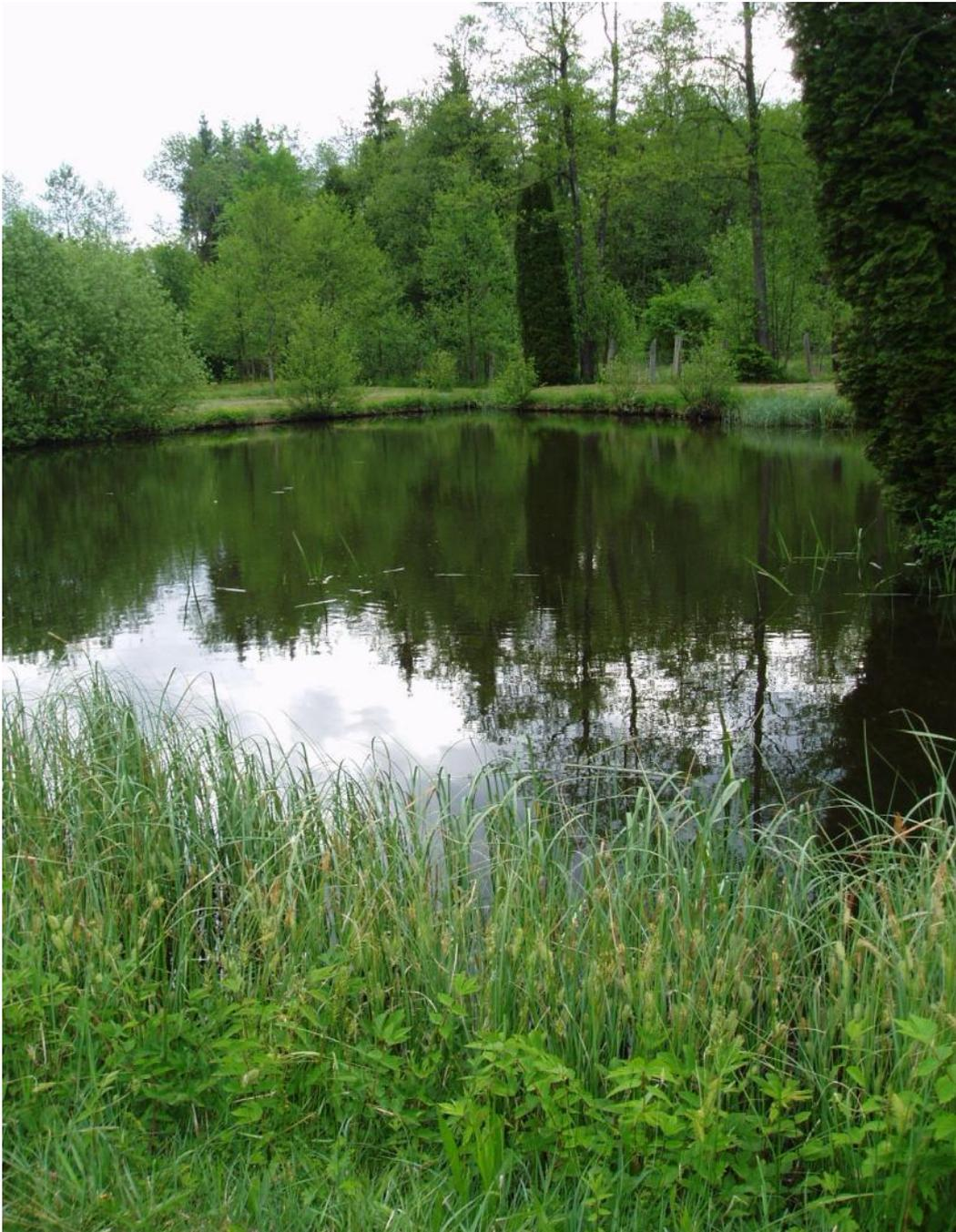
***Hier das Beispiel eines naturnah geschaffenen Wasser-Rückhalteraumes durch Vertiefung und Aufweitung des Profils eines Grabenspeichers zu einem Grabenteich als Maßnahme für eine Katastrophenvorsorge. Eine Wasserentnahme für die Bewässerung von Kulturlächen oder als Löschwasser ist stets gewährleistet.***
