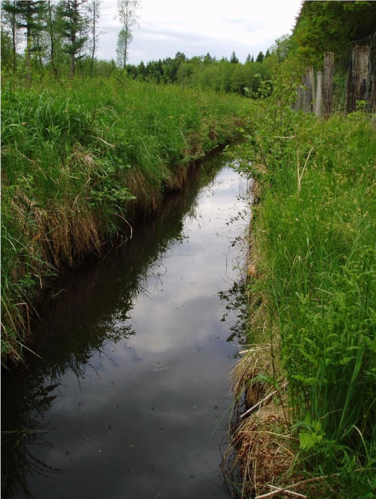
***Ein Beispiel für einen Grabenspeicher. Seine Länge von rund 200 m wird durch den natürlichen Uferbewuchs überdeckt. Hier können bis zu 400 m<sup>3</sup> Wasser gespeichert werden, welche ganzjährig zur Bewässerung von Kulturen oder als Löschwasser bei Bränden zur Verfügung stehen. Und „ganz nebenbei“ entsteht ein neues Biotop für die Aquafauna und -flora.***
