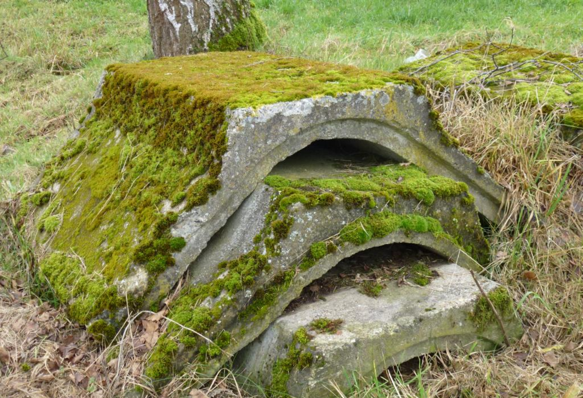
Kulturwasserbau: Auskleiden des Bachbettes mit Sohlschalen
